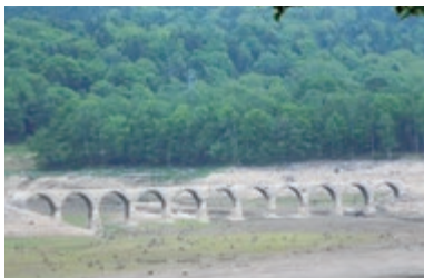
タウシュベツ川橋梁
